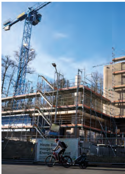
Erweiterungsbau Schulhaus Steinhof.
