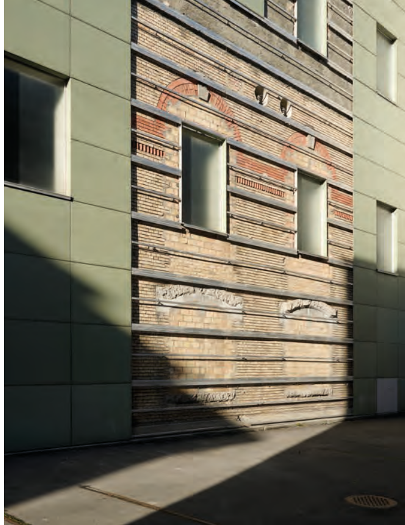
Das Unterwerk Steghof von Carl Griot sen. ist gut verborgen unter einer Vorhangfassade.
